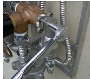
ボルトの締付は、最初に手締め状態で締付けてください。ボルトは、片締めにならないように、規定トルクで締付けて下さい。フランジの溝部に装着しているO-リングは新品に交換して下さい。
